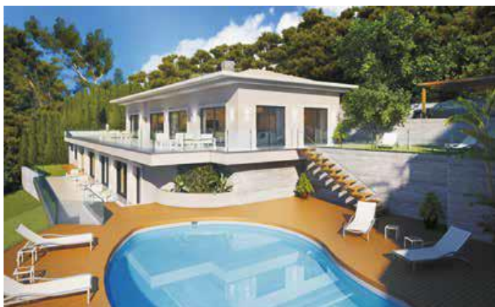
Soukromá vila v Eze (Francie): kompletní ovládání HVAC KNX komponenty, konfigurované výhradně z ETS
